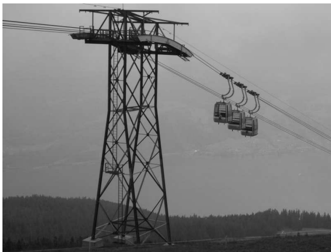
Abbildung 180: Dreiseil-Gruppenumlaufbahn von Streiff am Beatenberg.
